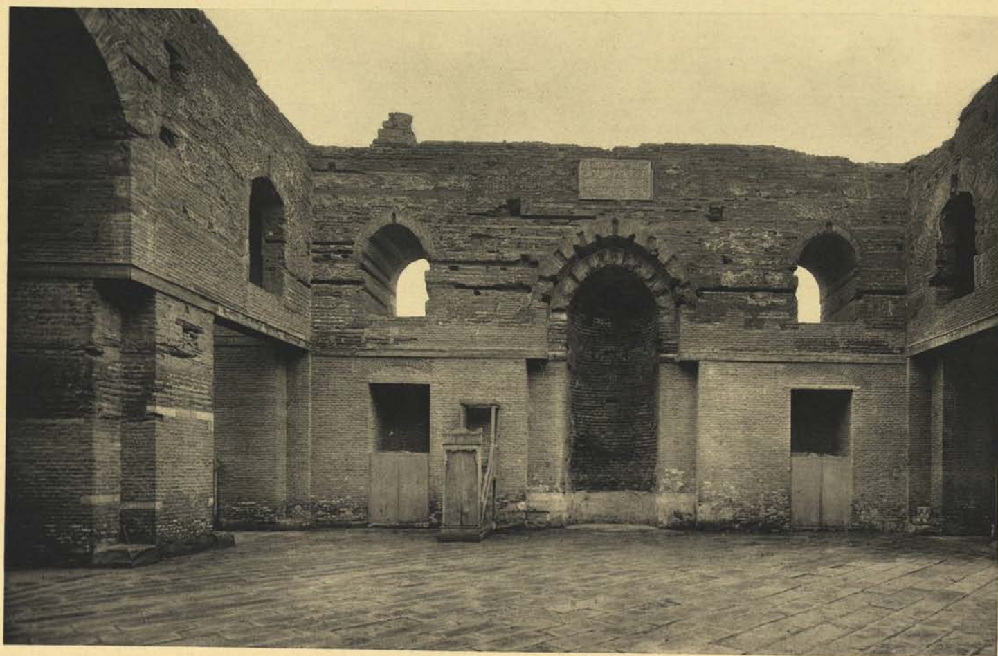
Mosquée de Baibars I er 1 Fenêtres du mur oriental 2 Travée centrale et mihrab
