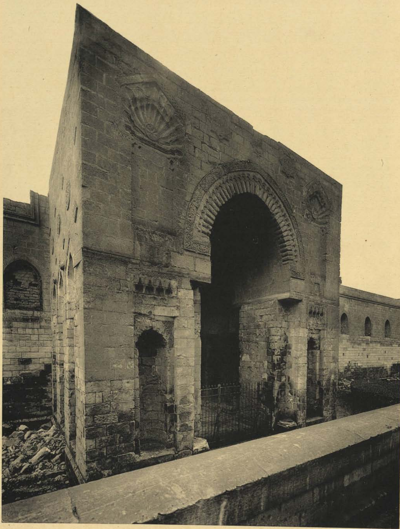
Porte de la Mosquée de Baibars Ier
