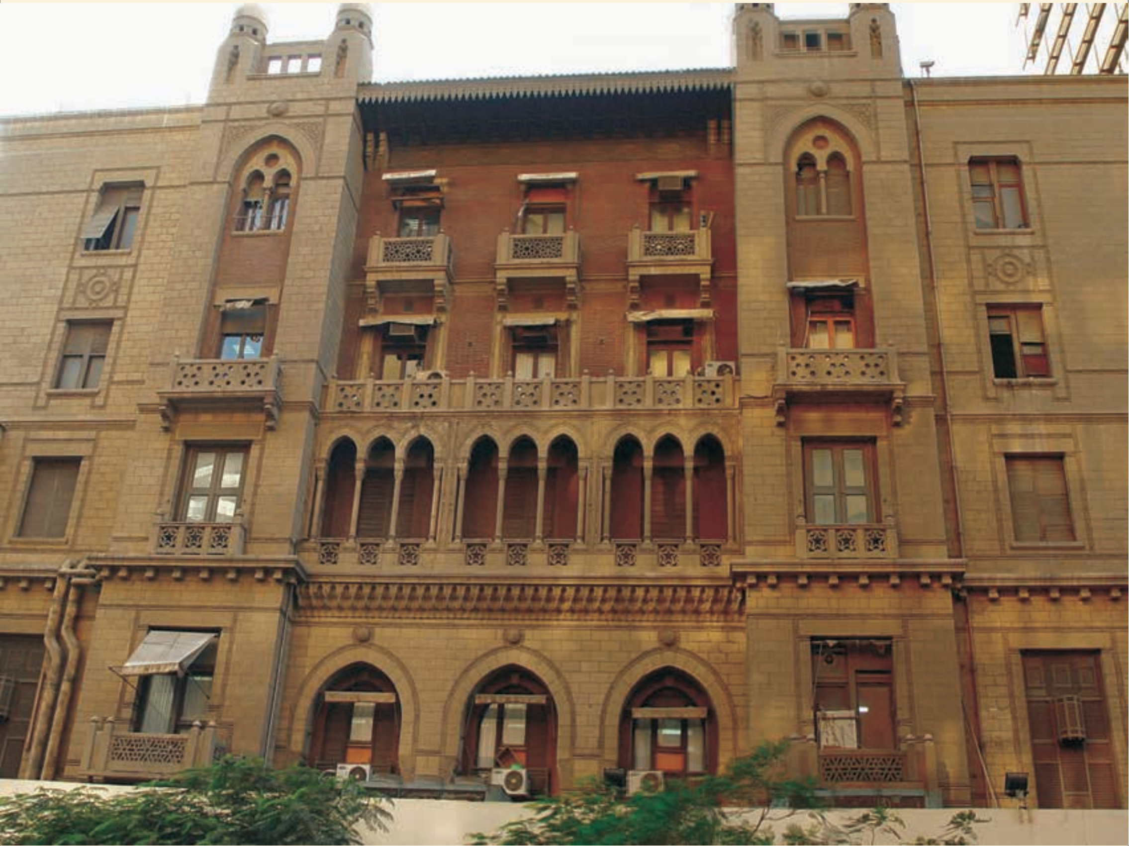
الواجهة الخلفية لمبنى البنك Banque Misr - main building rear facade.
