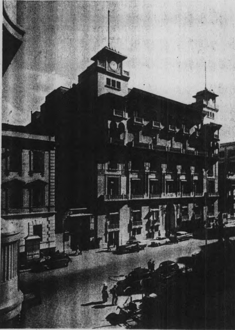
مبنى بنك مصر في فترة الخمسينات .
